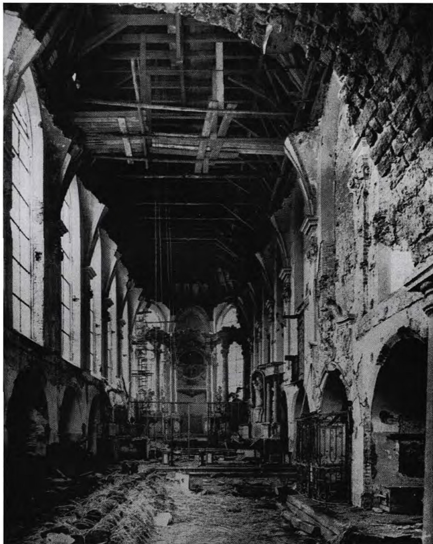
Blick auf die Zerstörungen des Altarraumes. Nur das Dach ist provisorisch geschlossen.
